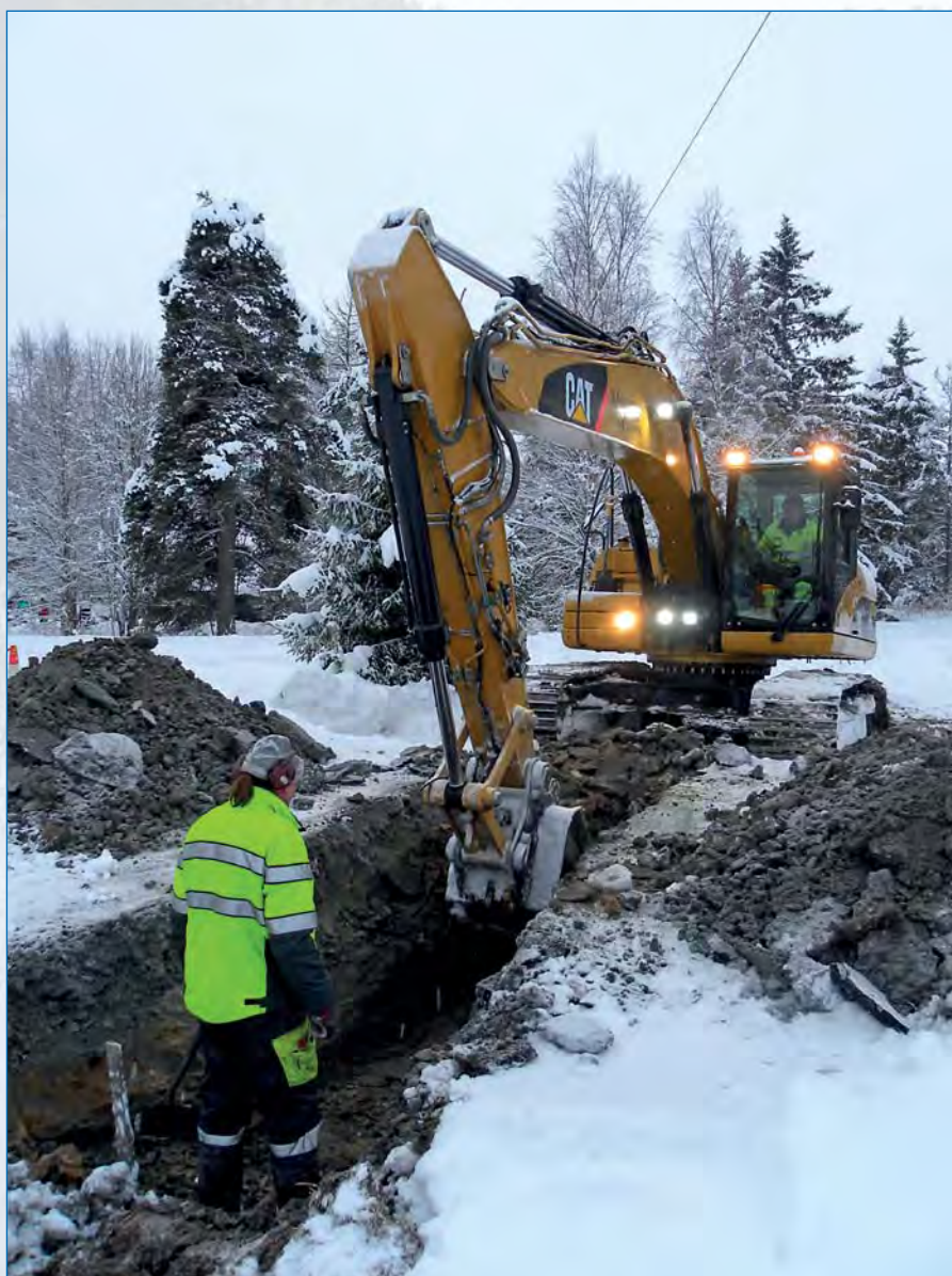
Etelä-Tammelan Vesihuolto Oy laajentaa viemäriverkostoaan Kallion kylään Riihivalkamassa. Kuva: Eija Laine
